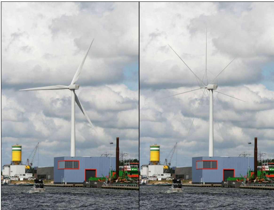
Figuur 4: De zeven kleiner bladen van de Corten-windturbine vallen meer weg in de achtergrond dan de drie grote bladen van een conventionele windturbine. Foto-editing door Paul Susan.
